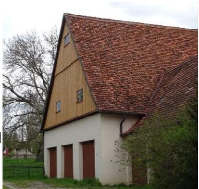
Bereits bei der Bauschau 2020 sind die Mängel an der Holzverkleidung der Westfassade sowie ein beschädigtes Fenster entdeckt worden. Nun konnte die Sanierung in diesem Frühjahr angegangen werden. Hierfür hat das Gremium dem ortsansässigen Zimmereibetrieb Feil den Auftrag erteilt.
